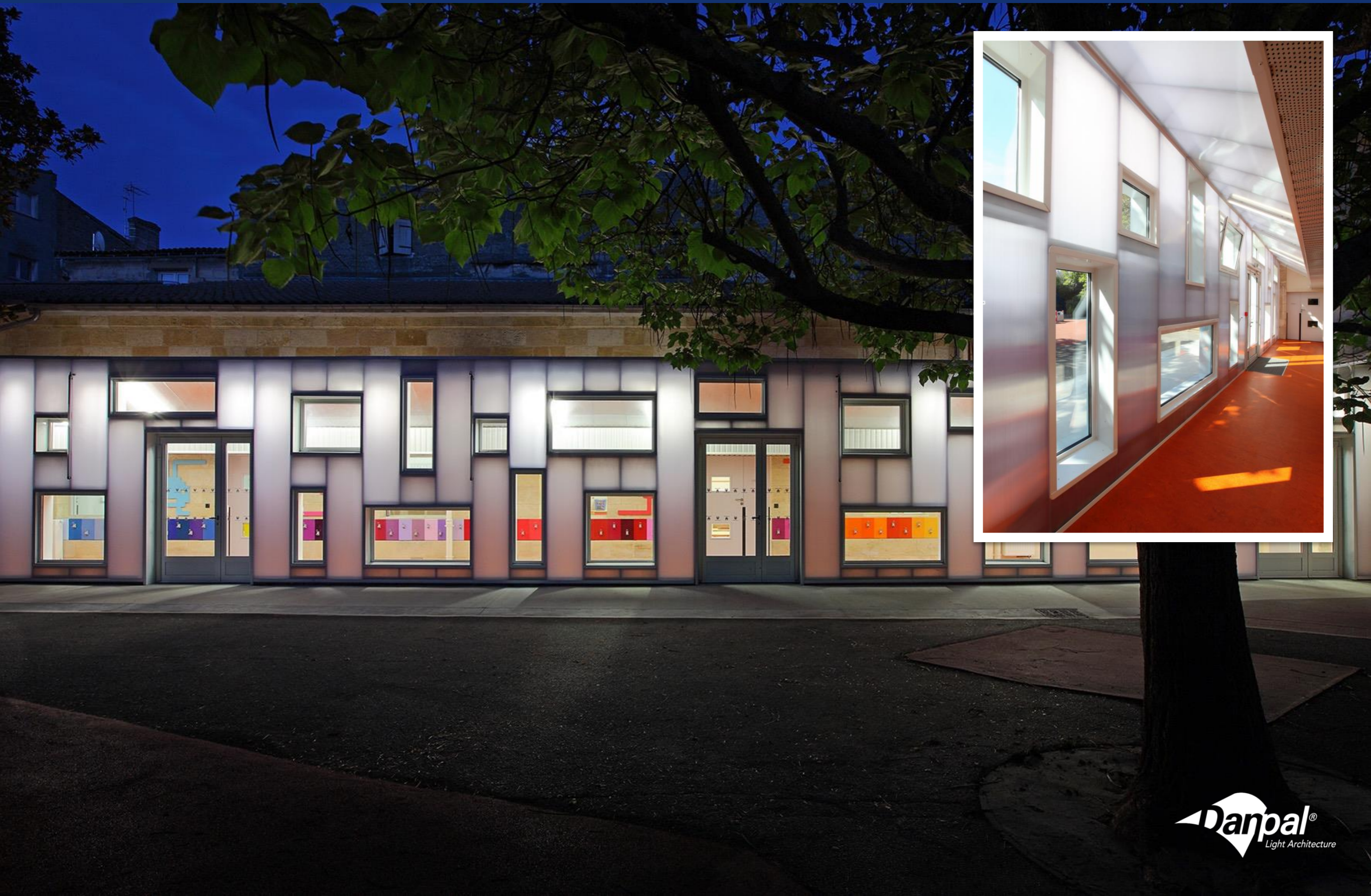
Education Center ,Julien Gadrat architecte dplg, France
